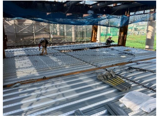
鉄板の溶接作業
