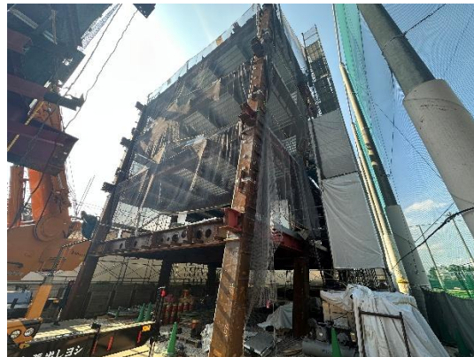
新校舎建築区画の様子
