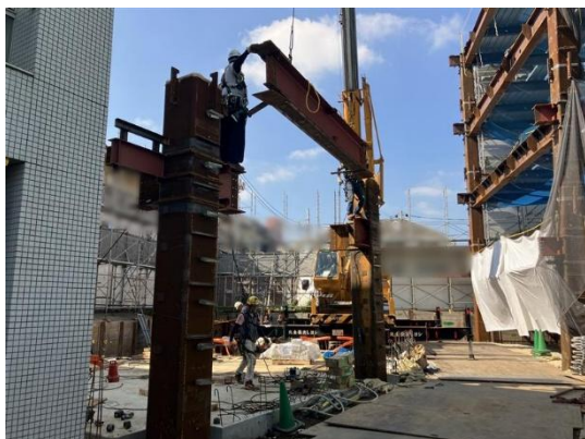
廊下建築区画の様子
