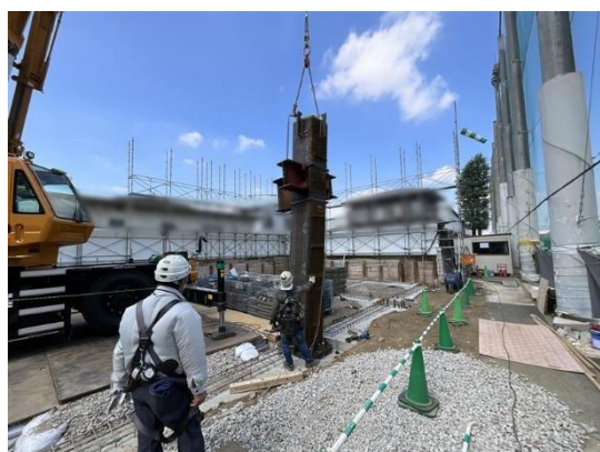
柱の接合作業
