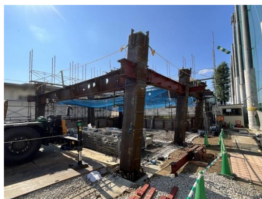
新校舎建築区画の様子
