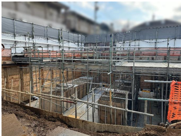
基礎足場①
