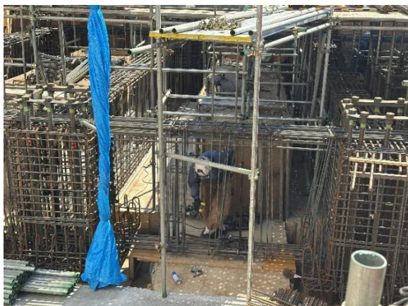
鉄筋が組まれる様子
