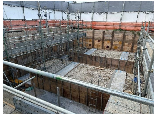
基礎足場②
