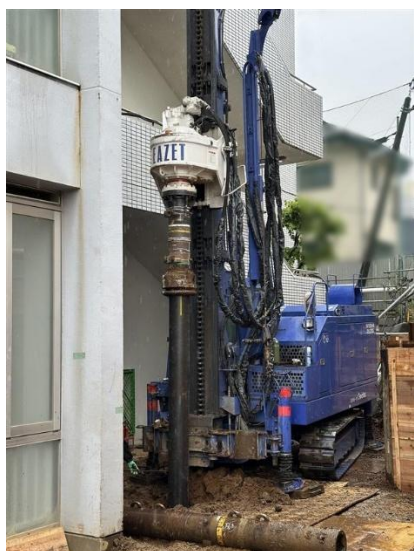
杭が埋め込まれる様子
