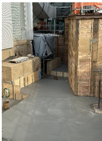
打設された「捨てコン」
