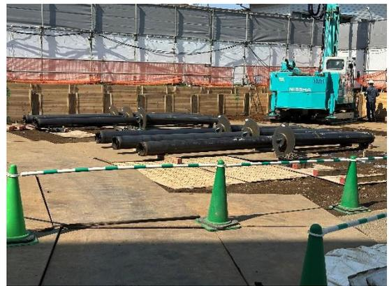
白雲館建設工事では、杭工事において、スクリーパイル EAZET（イーゼット）工法を用いており、先端にらせん状の翼の付いたスクリーパイルという鋼管杭を杭打ち機で回転させながら埋め込み、その上に通常の鋼管杭をボルト接合してさらに埋め込む、低騒音・低振動・無排土が特徴の工法で作業は進められております。
