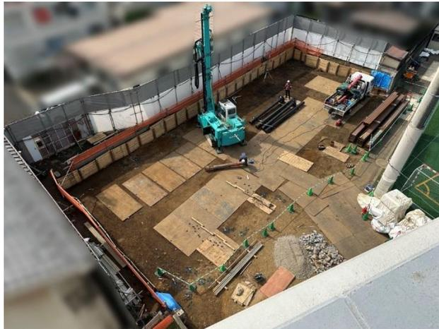
前回の「建設レポート②」でご報告させていただいた「山留め」作業が終わり、「杭打ち機」が運び込まれました。その名の通り「杭工事」で使用される建設機械です。
