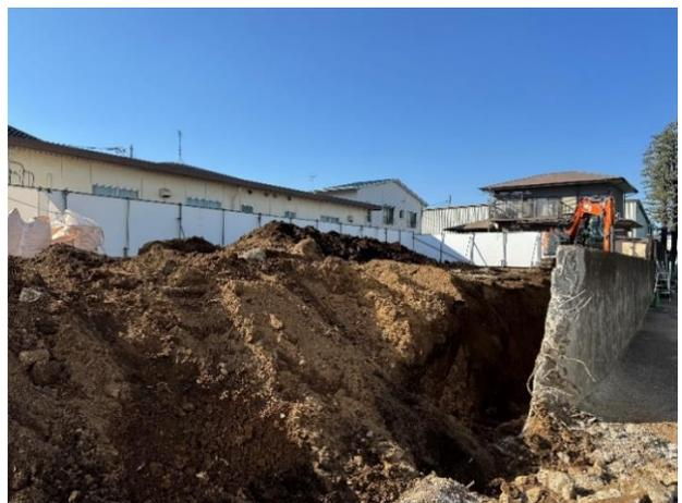
この作業で、約 400 立方メートルもの土と、約 60 トンのコンクリート瓦礫を搬出しました。
