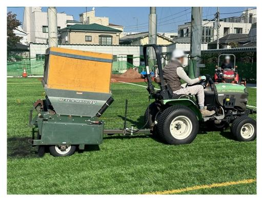
硅砂→ゴムチップ→硅砂→ゴムチップといった順に繰り返し撒き、最上段に緑色のゴムチップを撒き終えると、計8層で高さ4cmの層が出来上がります。
