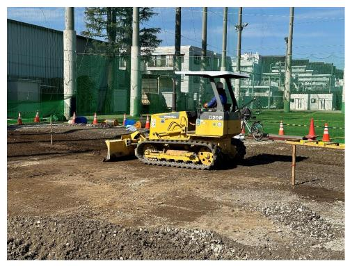
13日には敷き詰めた砕石の隙間を埋める砂の搬入がされました。 後期工事では、砕石 390トン・砂 36トンも使用します。
