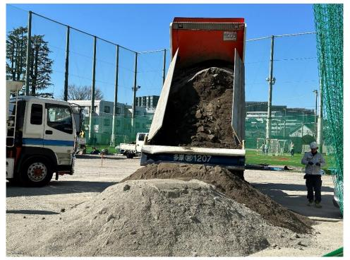
砕石と砂の敷き詰めが終わると、ロードローラーでの転圧を行いより強固な地盤を作ります。
